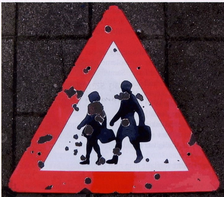
Et eksempel på den sidste generation af vejstavler i emalje. En farestavle lavet efter 1953 uden forhøjet kant og med sorte symboler.
